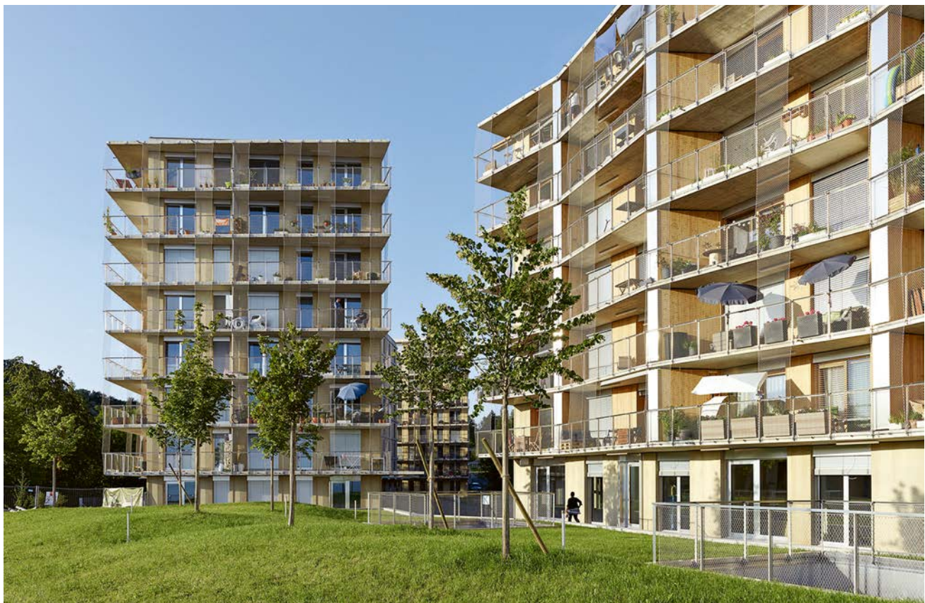
Oben: Blick von der Avenue de la Sallaz auf das Gebäude A. Der öffentliche «Place des Falaises» bildet den Auftakt ins Quartier. Auf der lärmigen Strassenseite bilden die Fassaden eine geschlossene Front, im Sockel sind öffentliche Nutzungen untergebracht. Unten: Ansicht auf die drei Gebäude von der Esplanade aus. Die Balkone an der Stirn und auf der ruhigen Rückseite bieten einen Blick ins Grüne und Platz für die individuelle Entfaltung der Bewohnerinnen und Bewohner.
