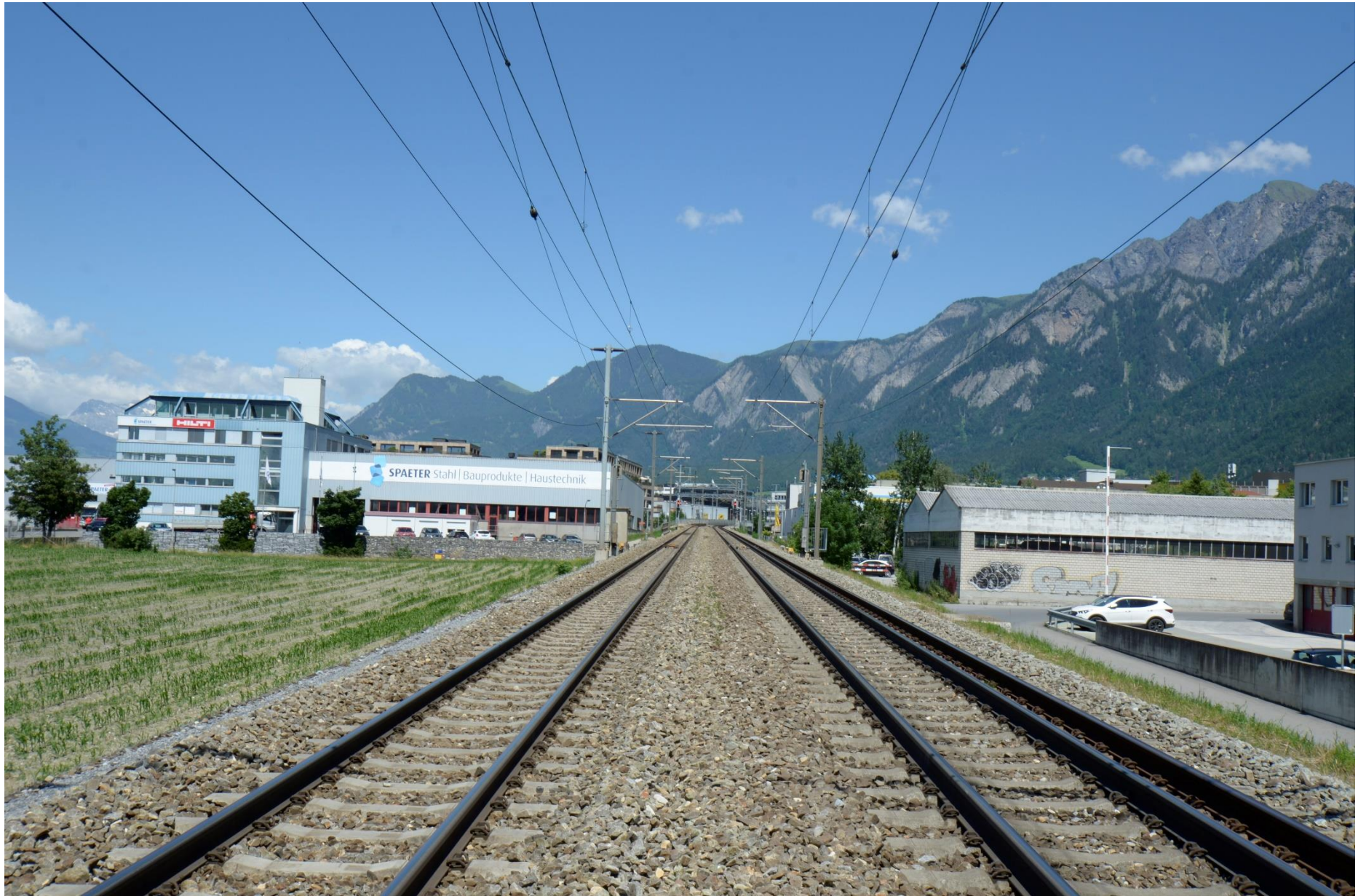
Fotodokumentation Neue Bahnstation Chur West, Querung Raschärenstrasse
