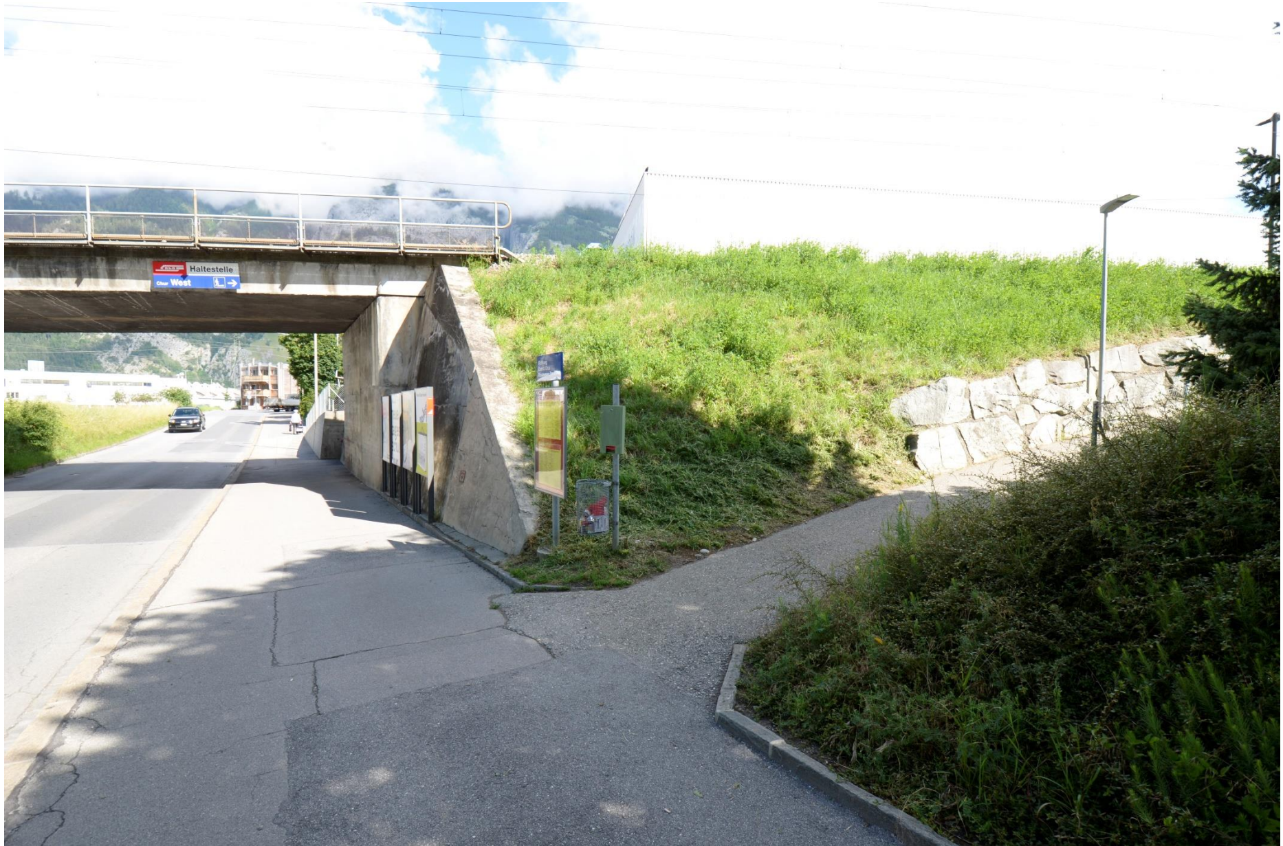
Fotodokumentation Neue Bahnstation Chur West, Querung Raschärenstrasse
