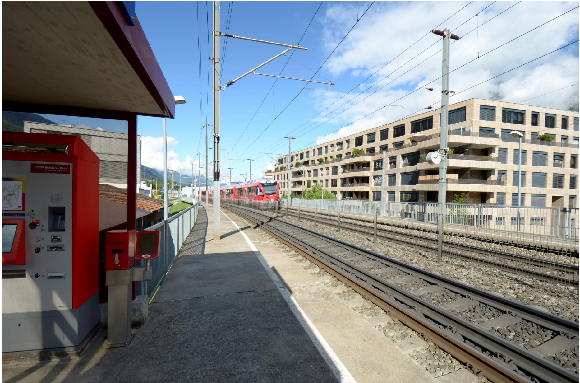
Fotodokumentation Neue Bahnstation Chur West, Querung Raschärenstrasse
