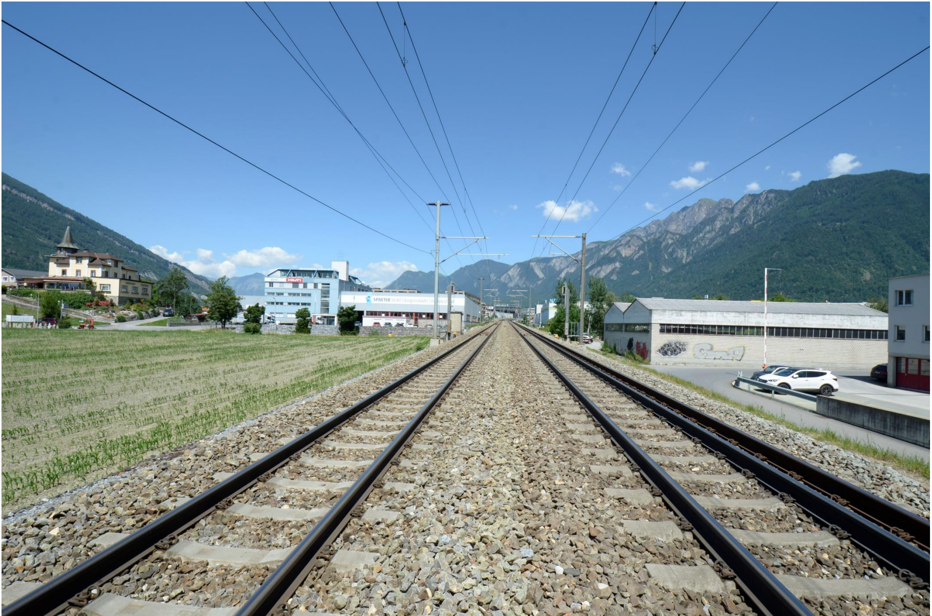
Fotodokumentation Neue Bahnstation Chur West, Querung Raschärenstrasse
