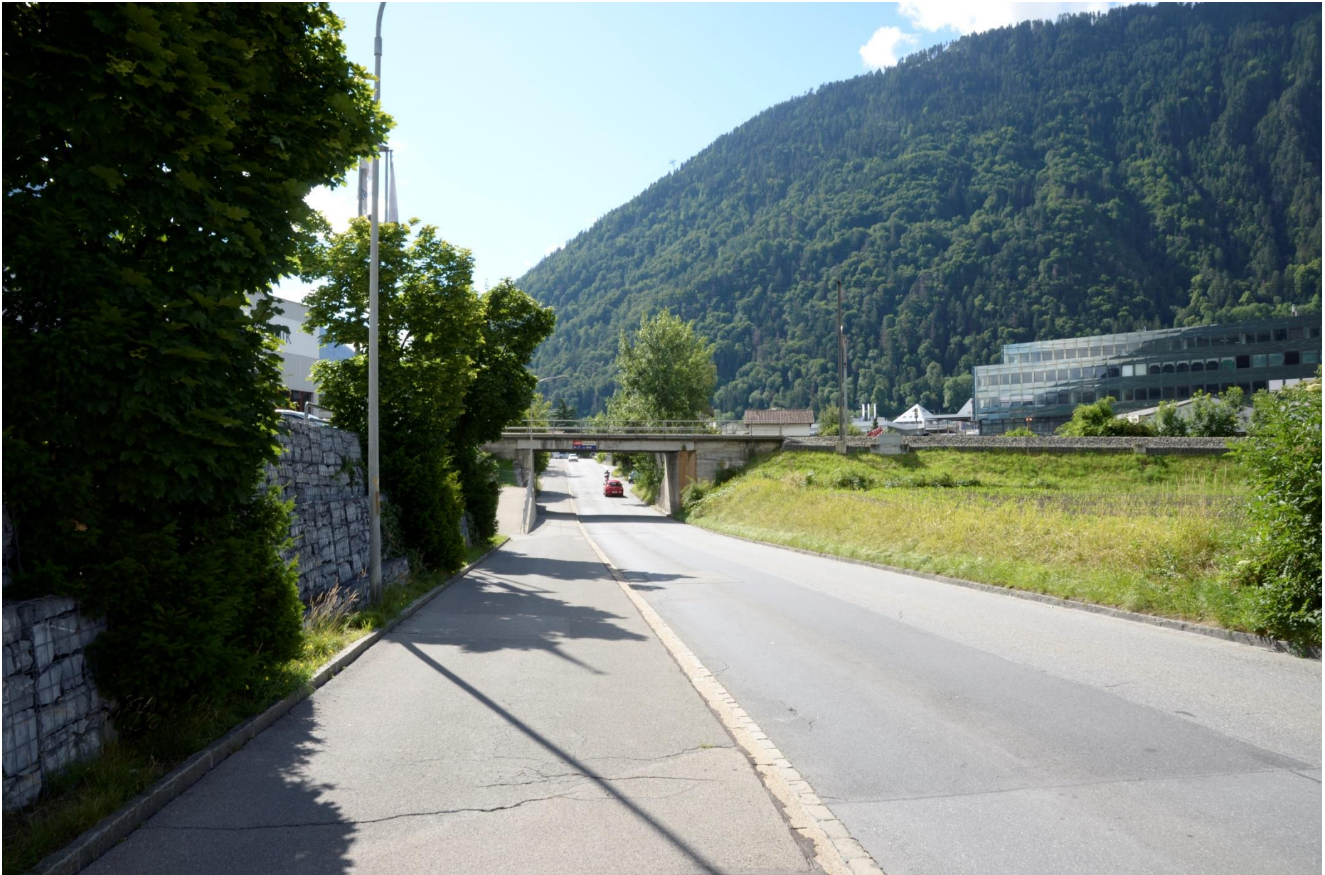
Fotodokumentation Neue Bahnstation Chur West, Querung Raschärenstrasse
