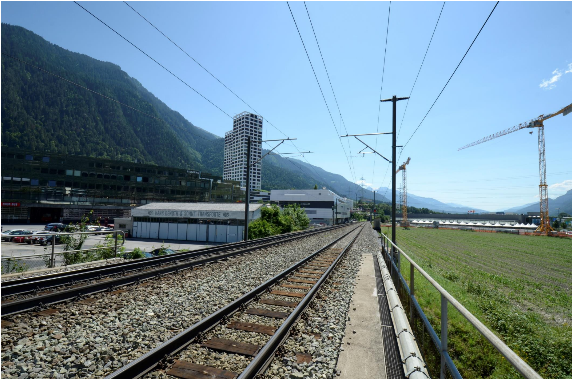
Fotodokumentation Neue Bahnstation Chur West, Querung Raschärenstrasse
