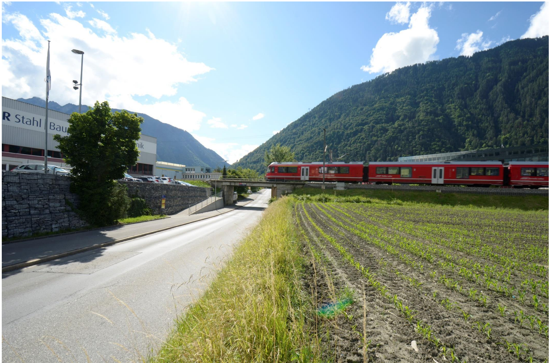
Fotodokumentation Neue Bahnstation Chur West, Querung Raschärenstrasse
