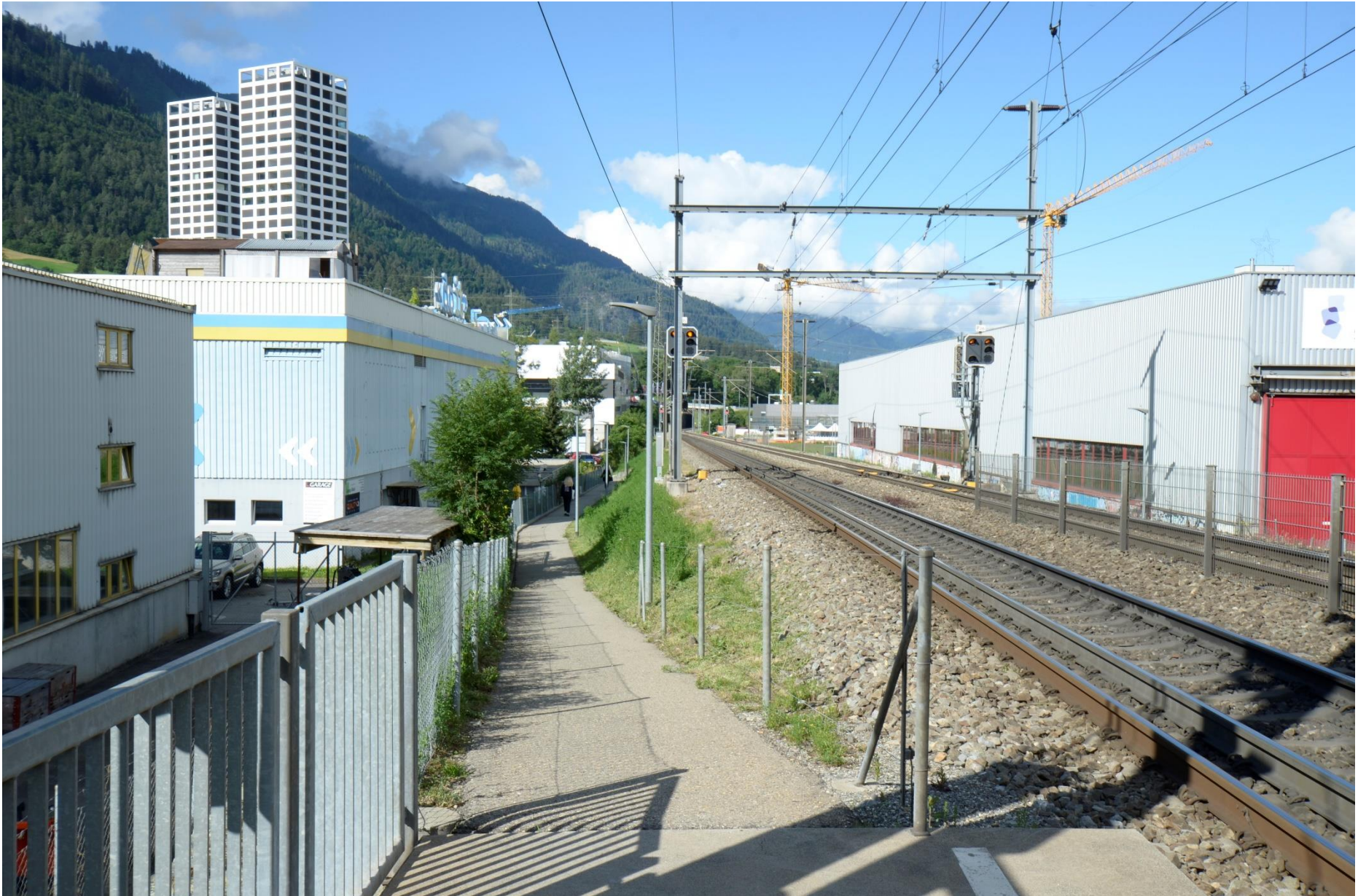
Fotodokumentation Neue Bahnstation Chur West, Querung Raschärenstrasse
