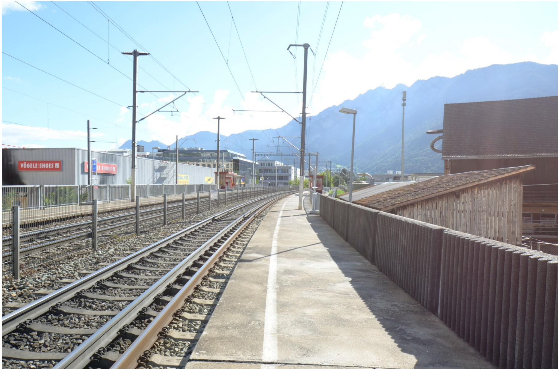
Fotodokumentation Neue Bahnstation Chur West, Querung Raschärenstrasse
