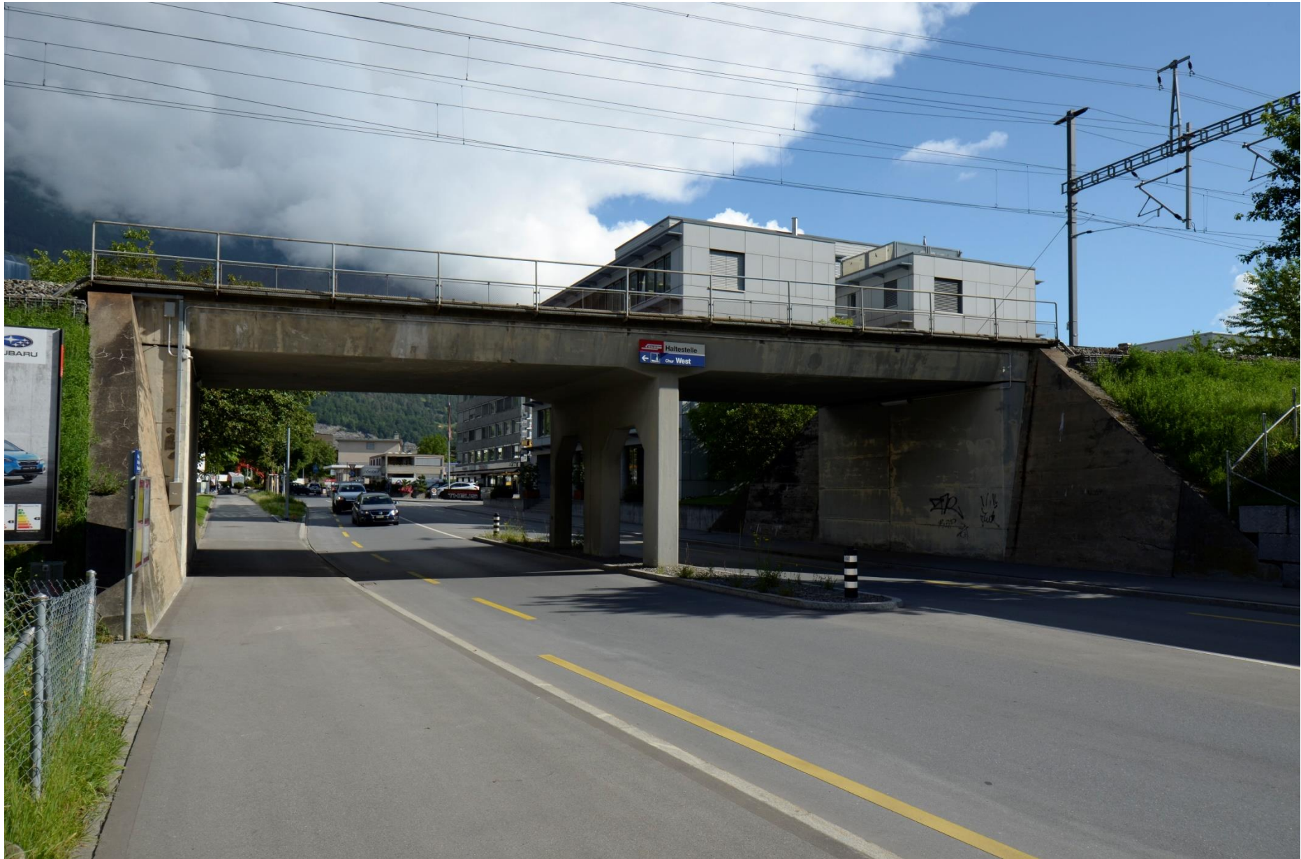
Fotodokumentation Neue Bahnstation Chur West, Querung Raschärenstrasse
