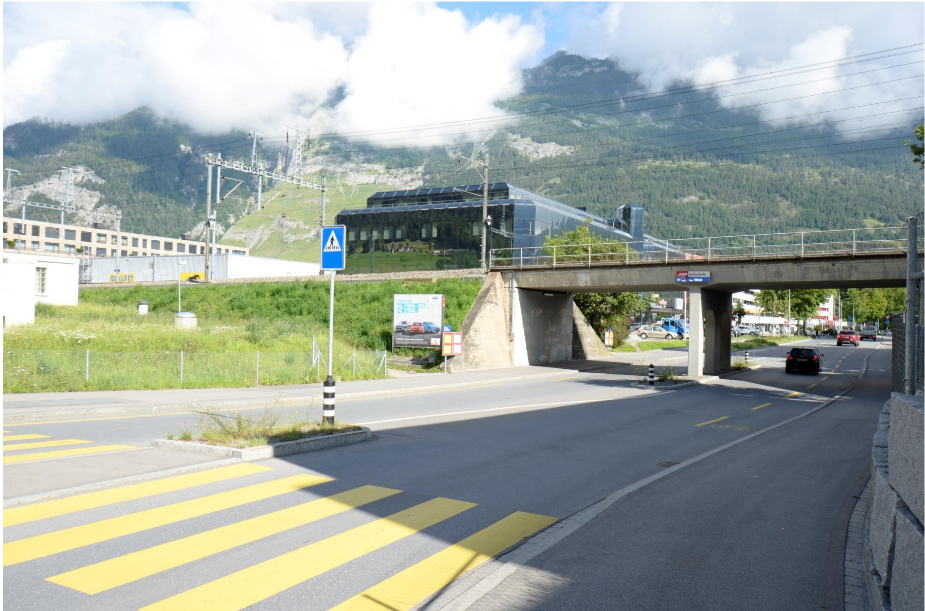
Fotodokumentation Neue Bahnstation Chur West, Querung Raschärenstrasse
