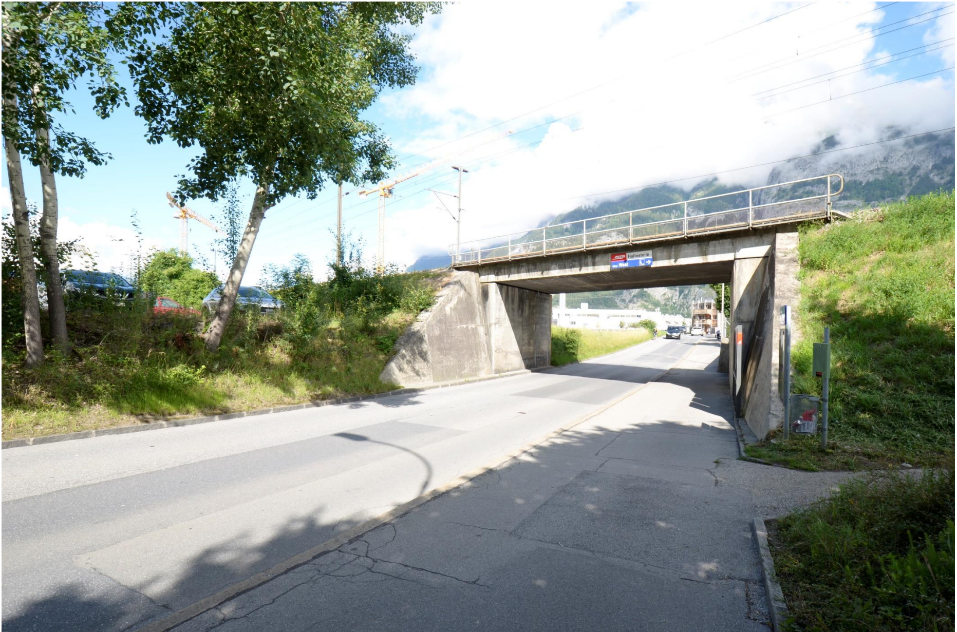
Fotodokumentation Neue Bahnstation Chur West, Querung Raschärenstrasse
