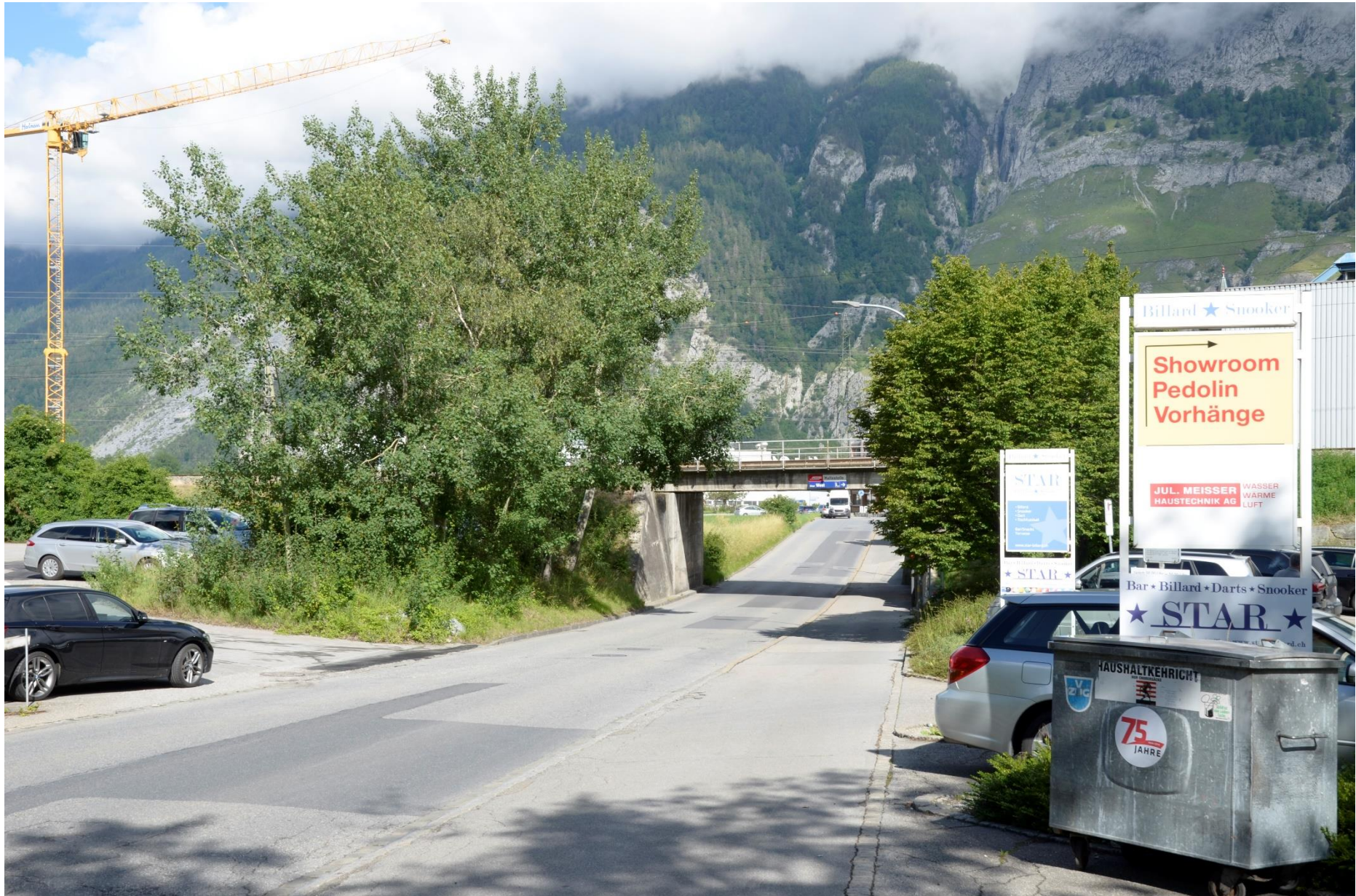
Fotodokumentation Neue Bahnstation Chur West, Querung Raschärenstrasse
