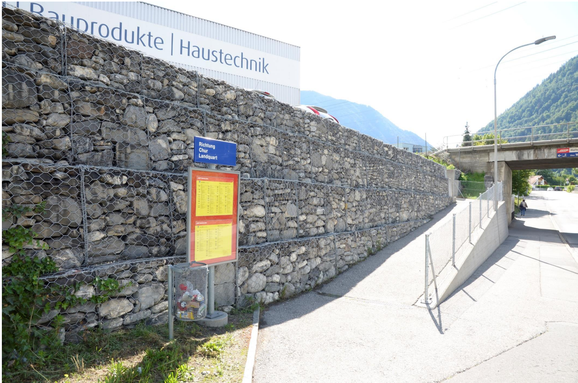
Fotodokumentation Neue Bahnstation Chur West, Querung Raschärenstrasse
