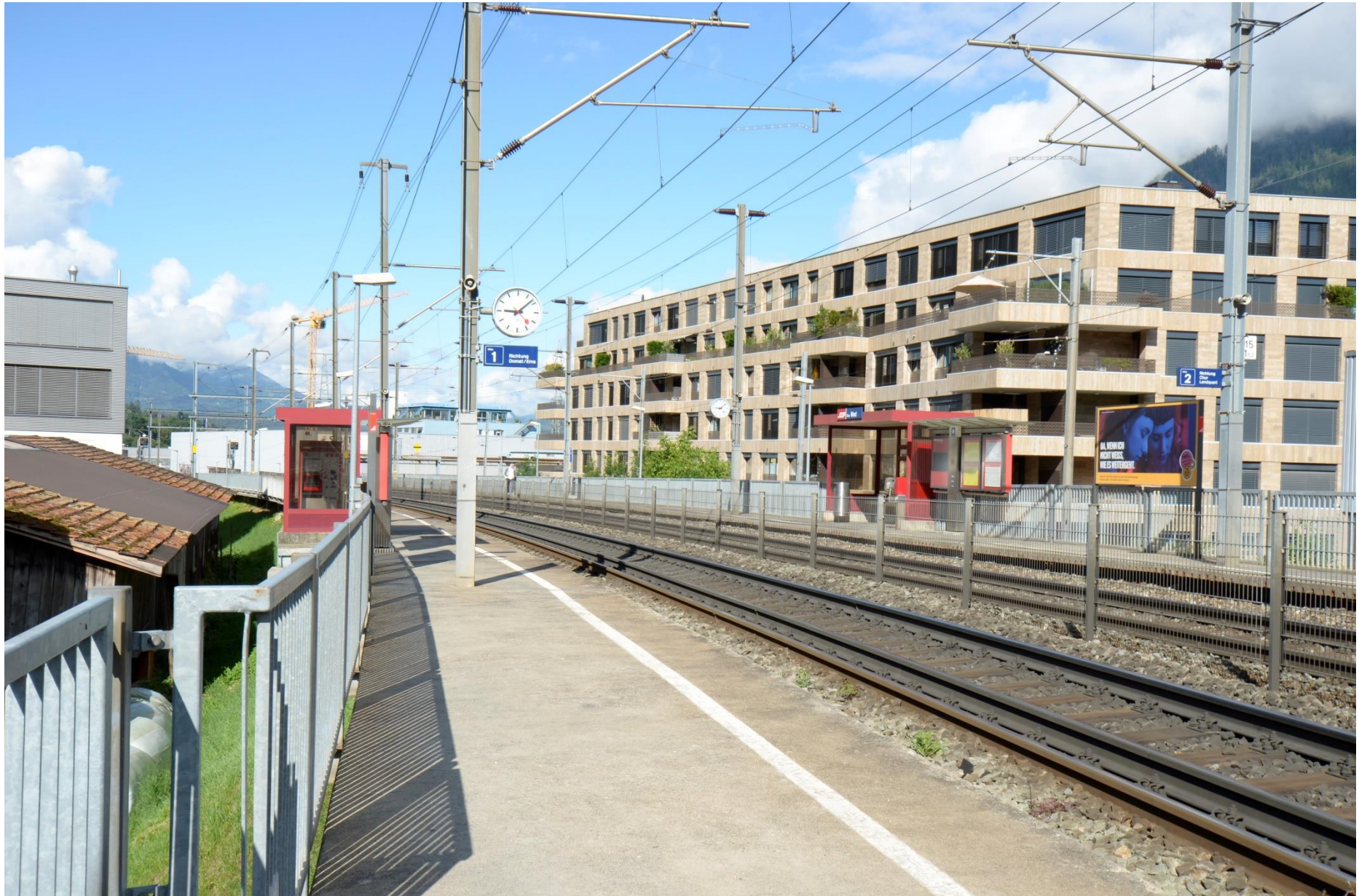
Fotodokumentation Neue Bahnstation Chur West, Querung Raschärenstrasse
