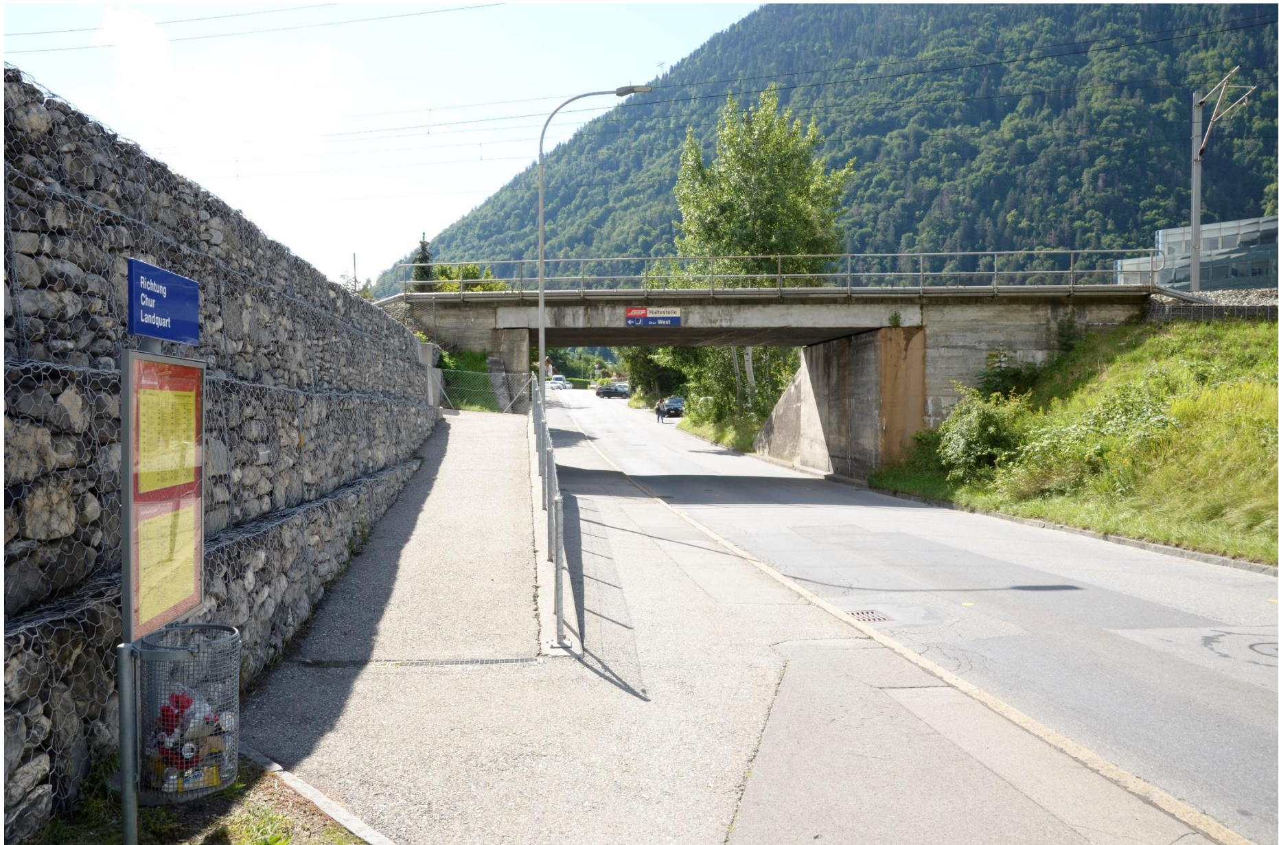
Fotodokumentation Neue Bahnstation Chur West, Querung Raschärenstrasse
