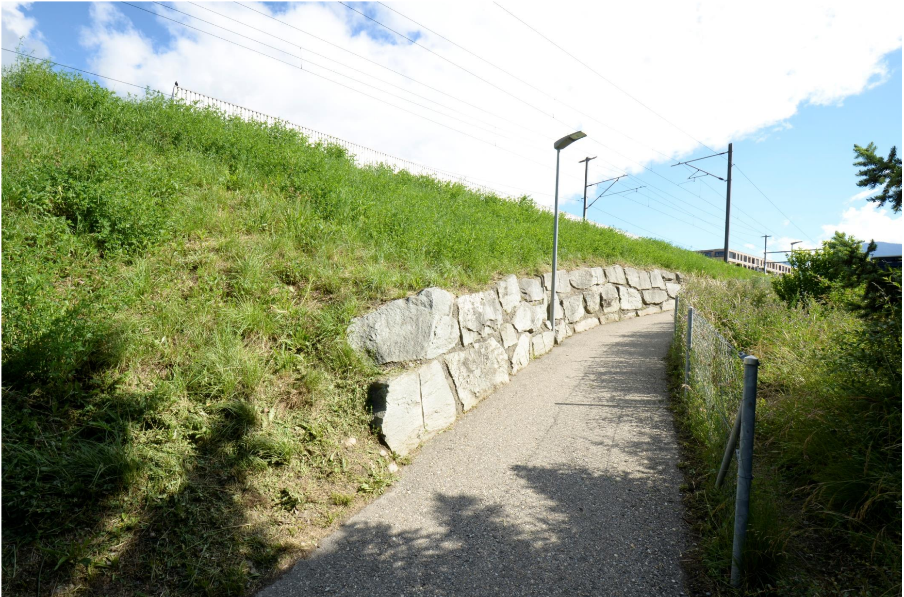
Fotodokumentation Neue Bahnstation Chur West, Querung Raschärenstrasse
