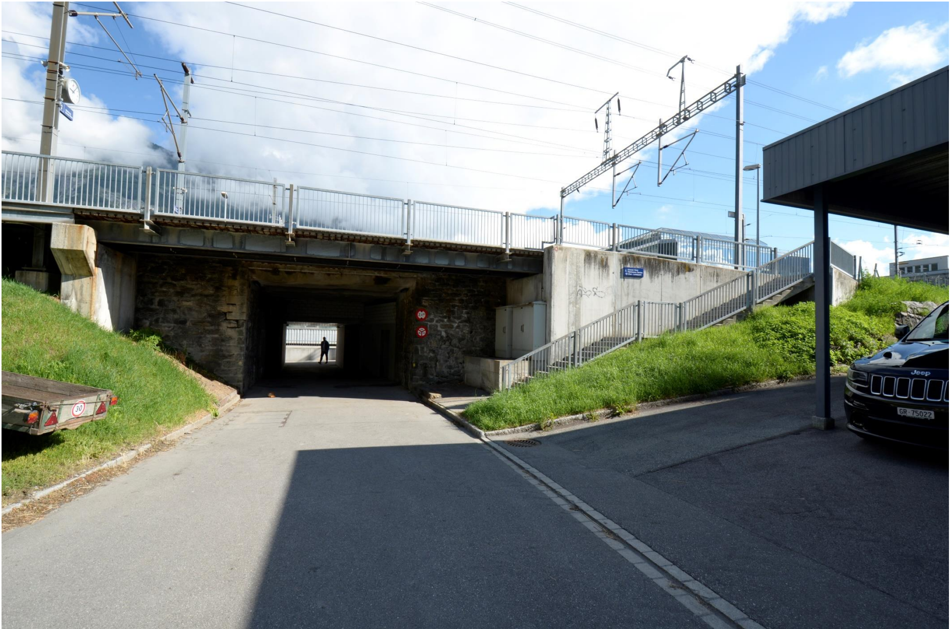
Fotodokumentation Neue Bahnstation Chur West, Querung Raschärenstrasse
