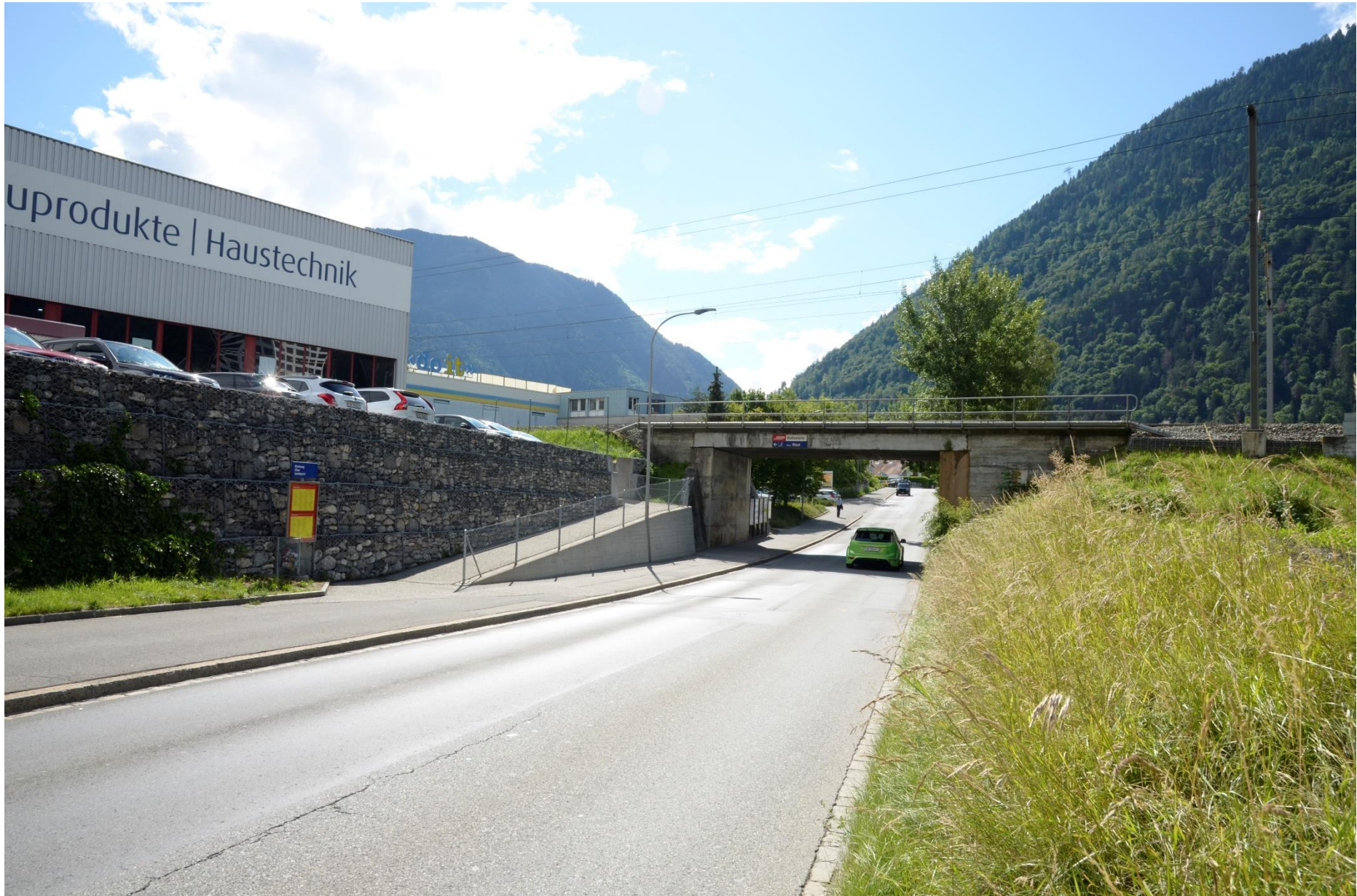
Fotodokumentation Neue Bahnstation Chur West, Querung Raschärenstrasse
