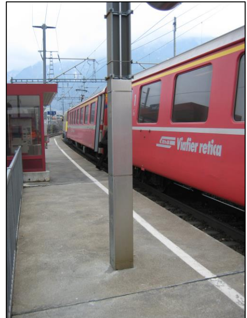
Hindernisse auf dem Perron. Die grosse Gleisüberhöhung am Zug ist sichtbar.
